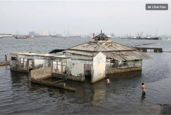
Warga beraktivitas di sekitar Masjid Wali Adhuna yang tergenang rob (air pasang laut), Muara Baru, Jakarta Utara, Sabtu (12/10/2019). Pemerintah Provinsi DKI Jakarta dan Kementerian Pekerjaan Umum dan Perumahan Rakyat (PUPR) mengambil alih pembangunan segmen tanggul laut National Capital Integrated Coastal Development ( NCICD) di utara Jakarta. (KOMPAS.com/M ZAENUDDIN)
